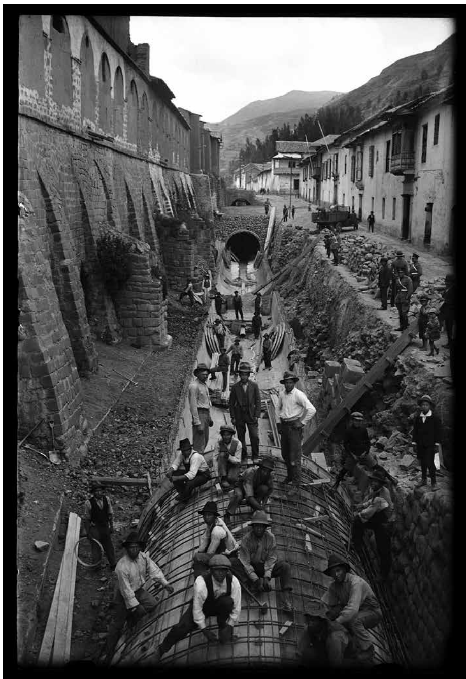
Trabajos de canalización de río en calle Saphi
