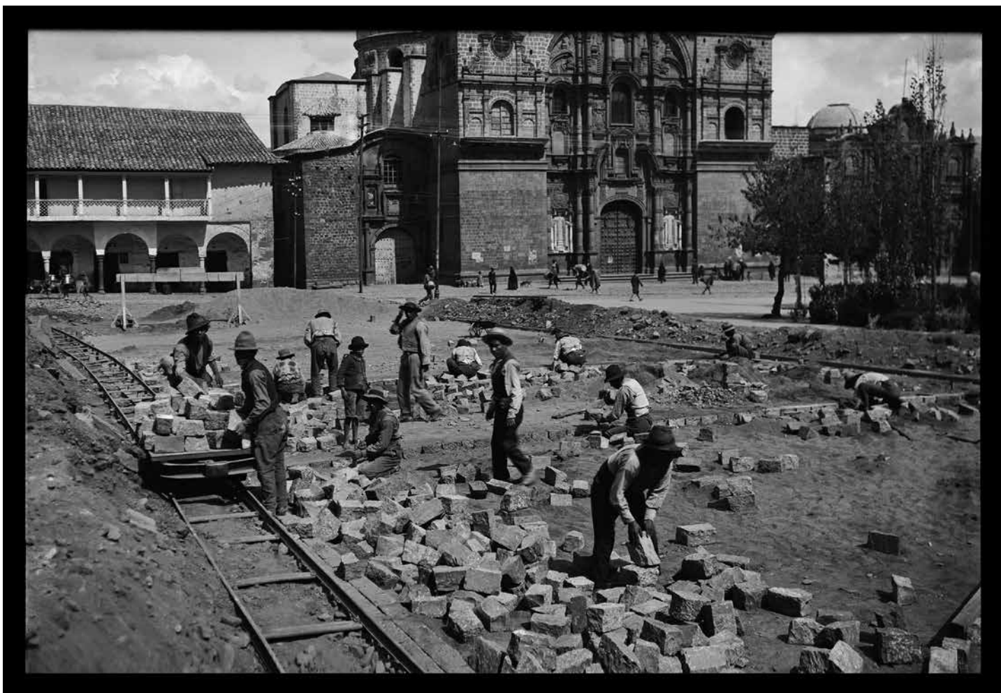
Trabajos de pavimentación de la Plaza de Armas
