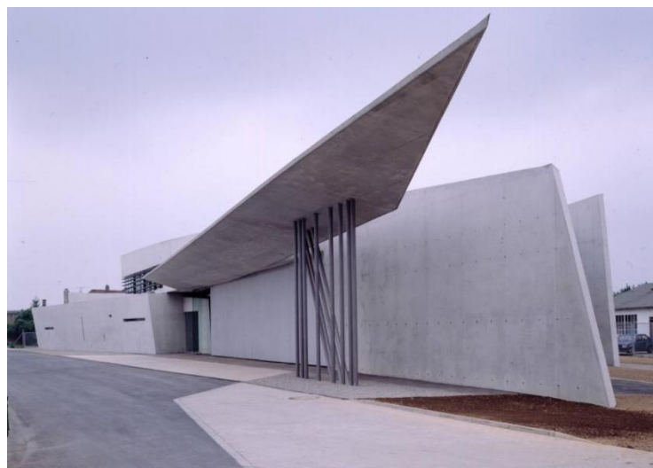
(Fig. 3) Estación de bomberos de la fabrica Vitra, primera construcción de Hadid, 1993. Well am Rhein, Alemania.
